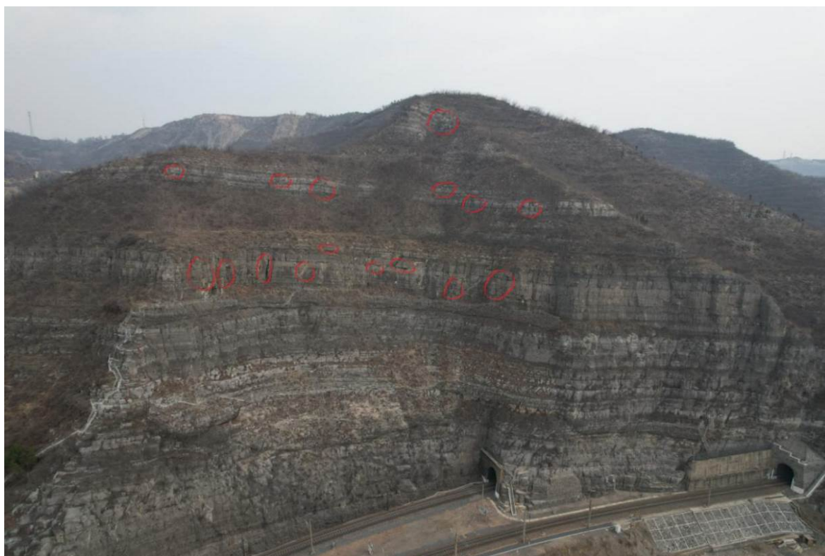
K375+544.00-K375+660.00 下行左侧坡危岩落石
