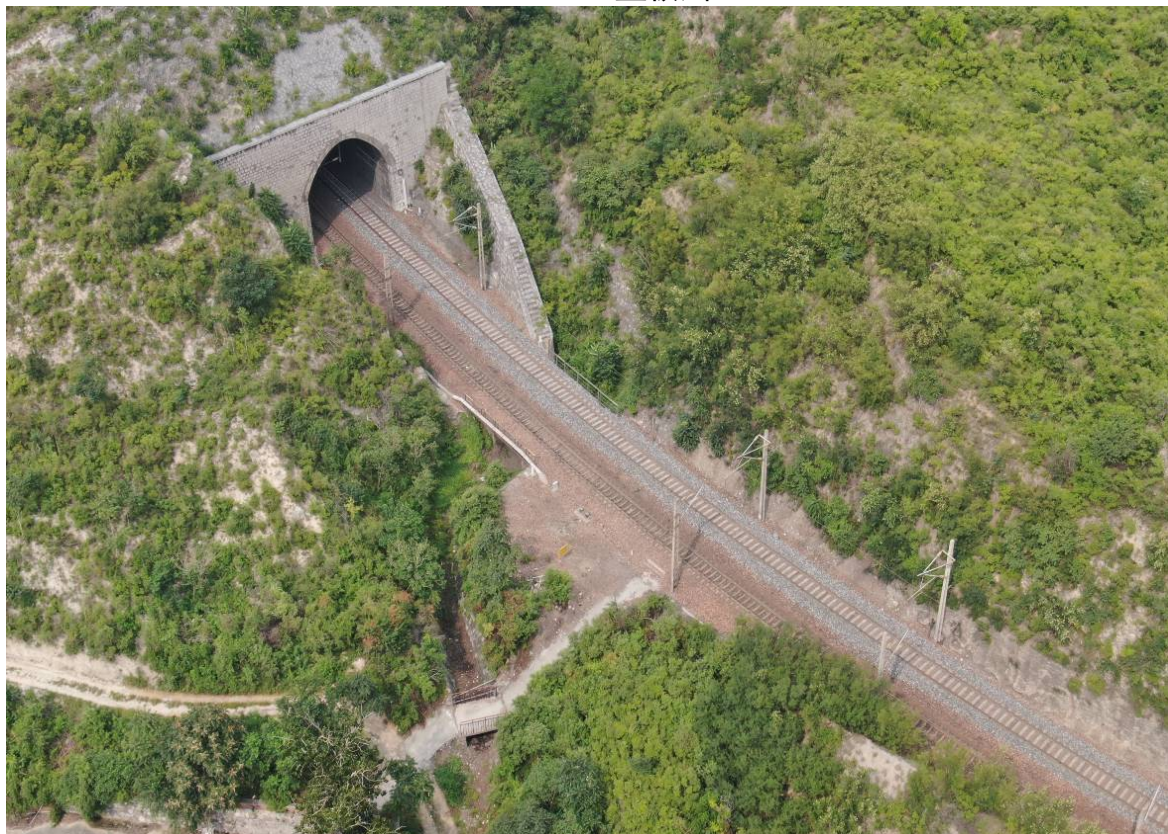
金沟小桥周边情况
