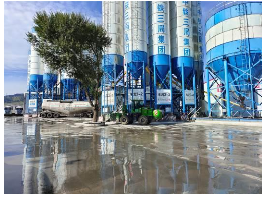
拌合站内场地清洗
