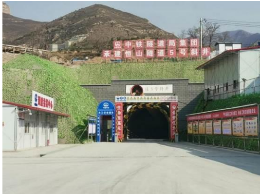
恒山隧道洞口及边坡的绿化、防护措施
