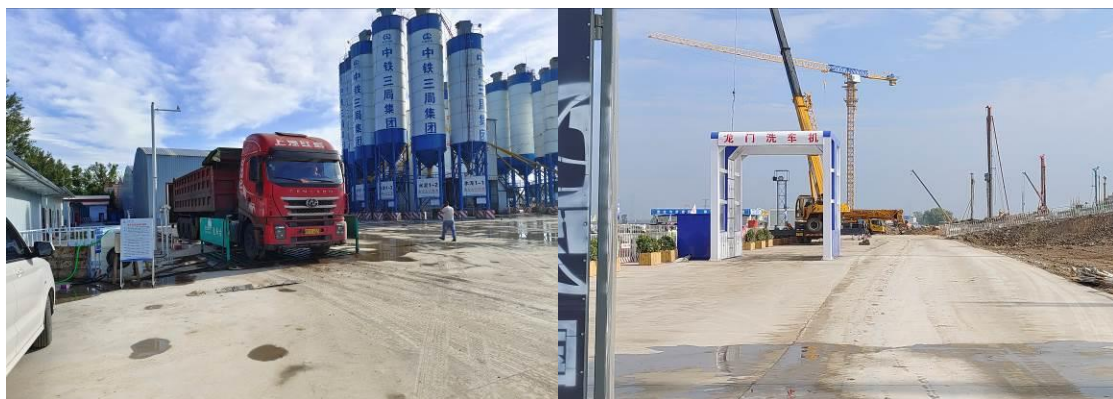
临时场站进出口洗车设施
