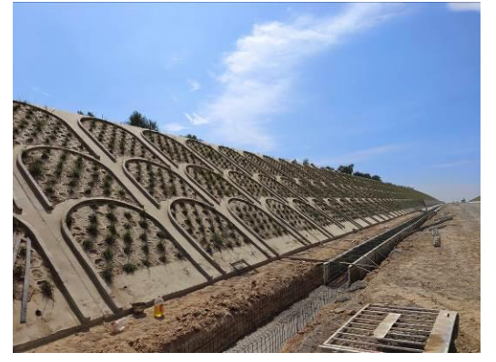
恒山隧道洞口及边坡的绿化、防护措施
