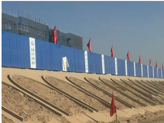
施工场地设置的硬质隔离
