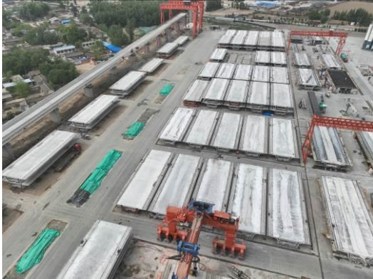
临时场站地面硬化、料仓全封闭
