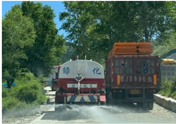
施工便道定时洒水降尘的洒水车
