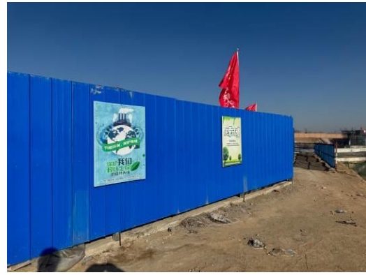
施工场地设置的硬质隔离
