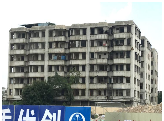
南侧待拆迁居民楼现状
