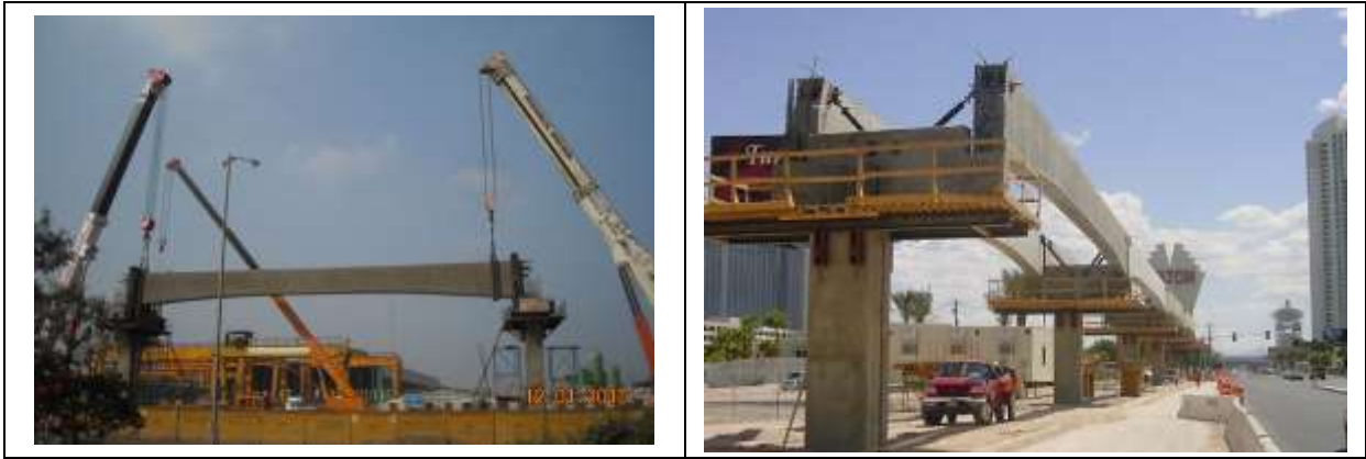
图 2.1-17 同类项目区间高架施工照片
